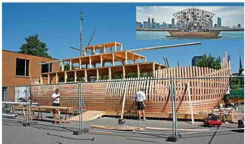
Das Ship of Tolerance in seiner Bauphase.
